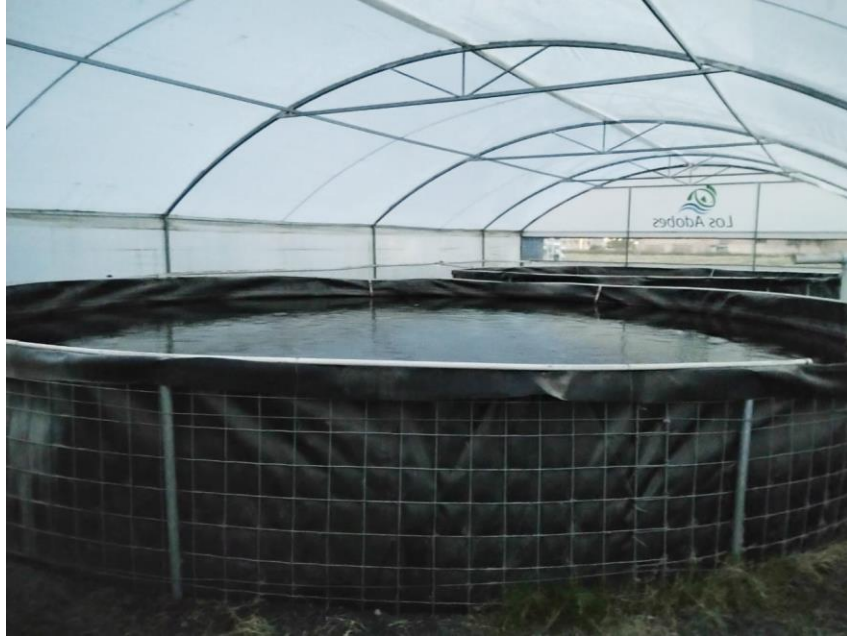
Figura 18. Estanque de geomembrana ubicados en la granja acuícola “Los adobes”.
