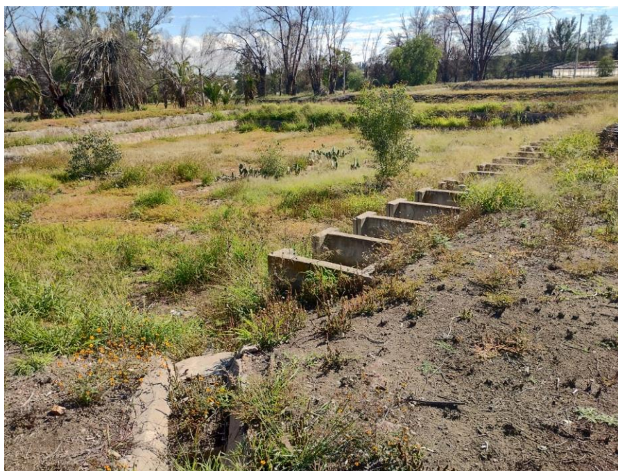
Figura 15. Instalaciones del centro acuícola sin uso por falta de agua.
